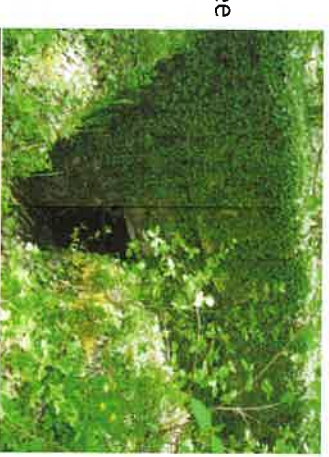
WP04 > casemate bétonnée et enterrée
